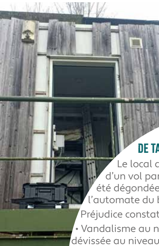
Entretien ouvrage Champ Courry
