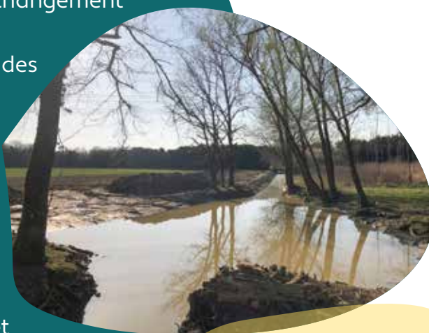
Mare Ambérieux après travaux
