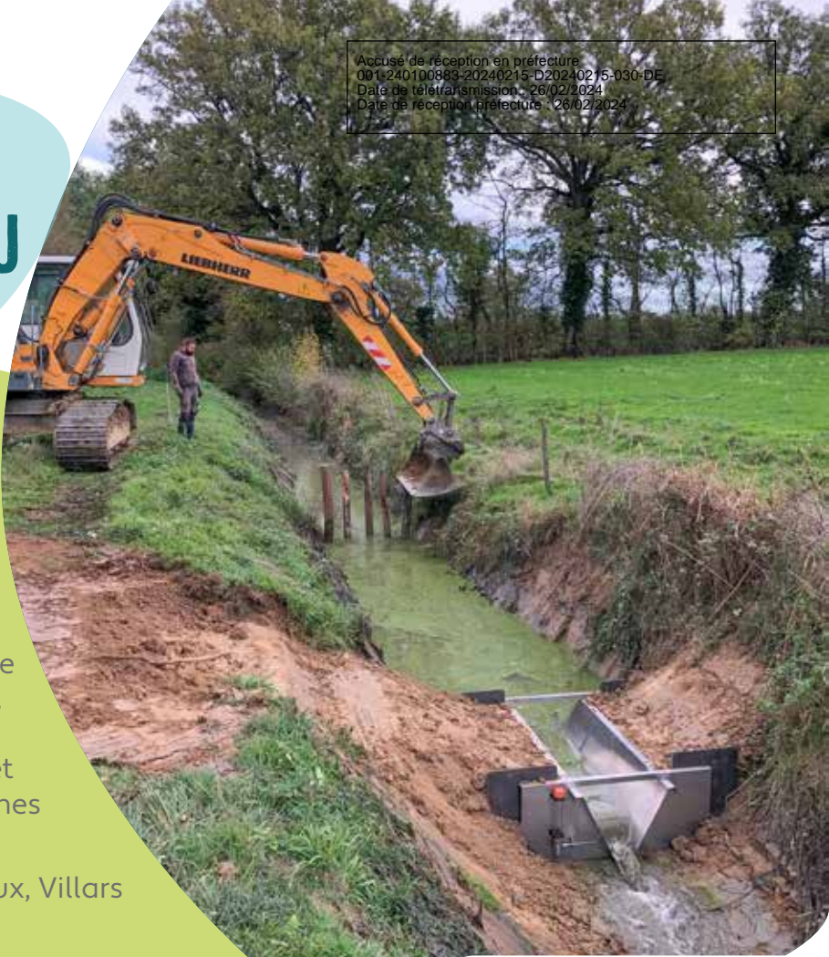
Installation d'un canal venturi à Joyeux
