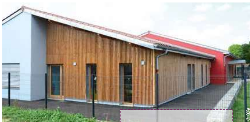
↑ Construction d'une école primaire et périscolaire à Sainte-Julie
